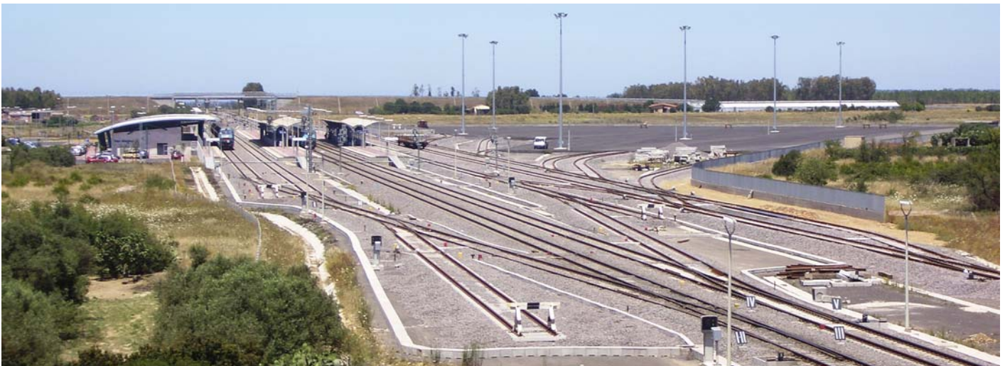
Una panoramica della nuova stazione ferroviaria di San Gavino Monreale; in basso, alcune tavole dal progetto.
