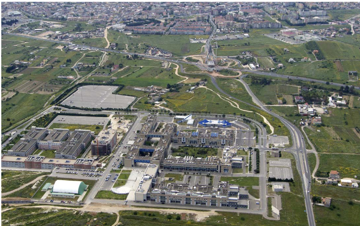
La Cittadella universitaria e il Policlinico; sullo sfondo il cantiere per il nuovo ponte e l'abitato di Monserrato (foto Aeronike - 9 maggio 2009)
