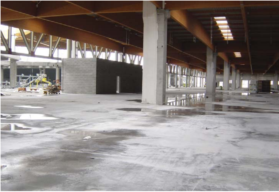
Centro commerciale di Carpi: pavimentazione industriale di circa 70.000 mq realizzata in calcestruzzo fibrorinforzato con RXF54 Ruredil.
