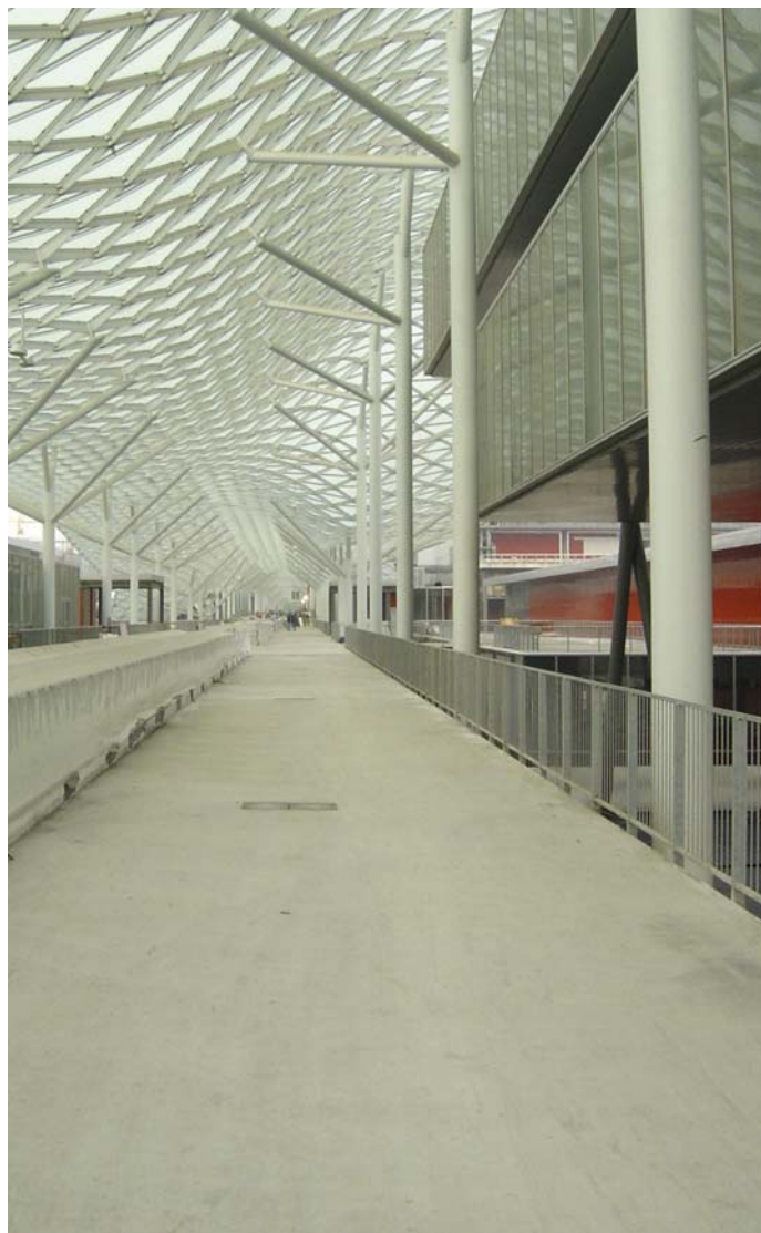
Nuovo Polo fieristico di Milano: pavimentazione della passerella dell'asse centrale realizzata in calcestruzzo fibrorinforzato con RXF54 Ruredil (lunghezza circa 1 km)
