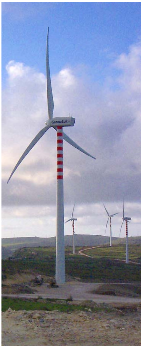
La centrale eolica di Florinas (SS).
