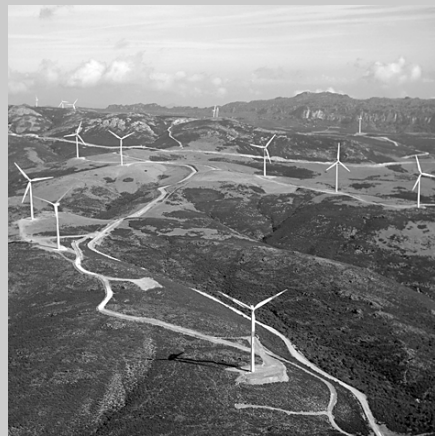
• in copertina: l'impianto eolico di Ulassai (foto Aeronike - Cagliari)
