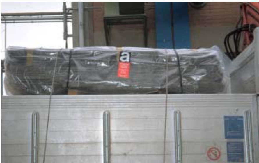
DOPO LA RIMOZIONE, LASTRE CON AMIANTO IMBALLATE PER IL TRASPORTO IN DISCARICA.
