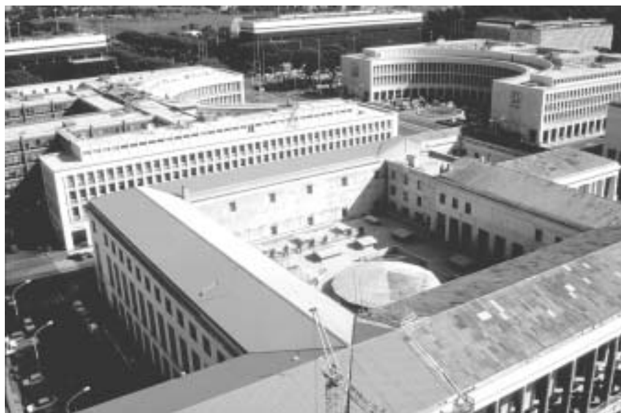
ROMA, SOSTITUZIONE DELLE COPERTURE DEL COMPLESSO MONUMENTALE DELL'EUR.
